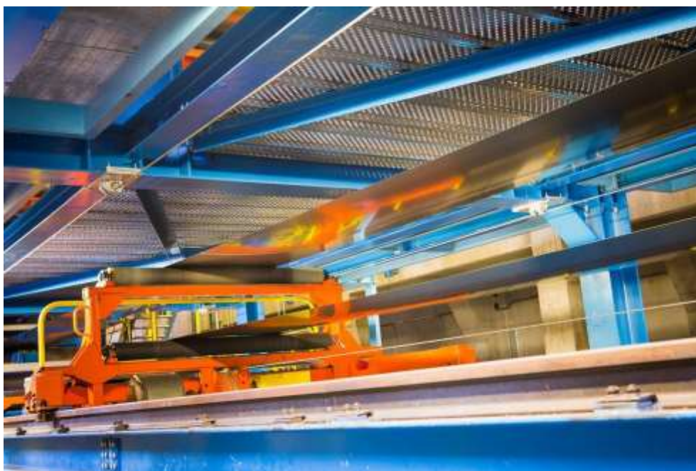
Accumulateur horizontal (ARCELORMITTAL Mardyck)
